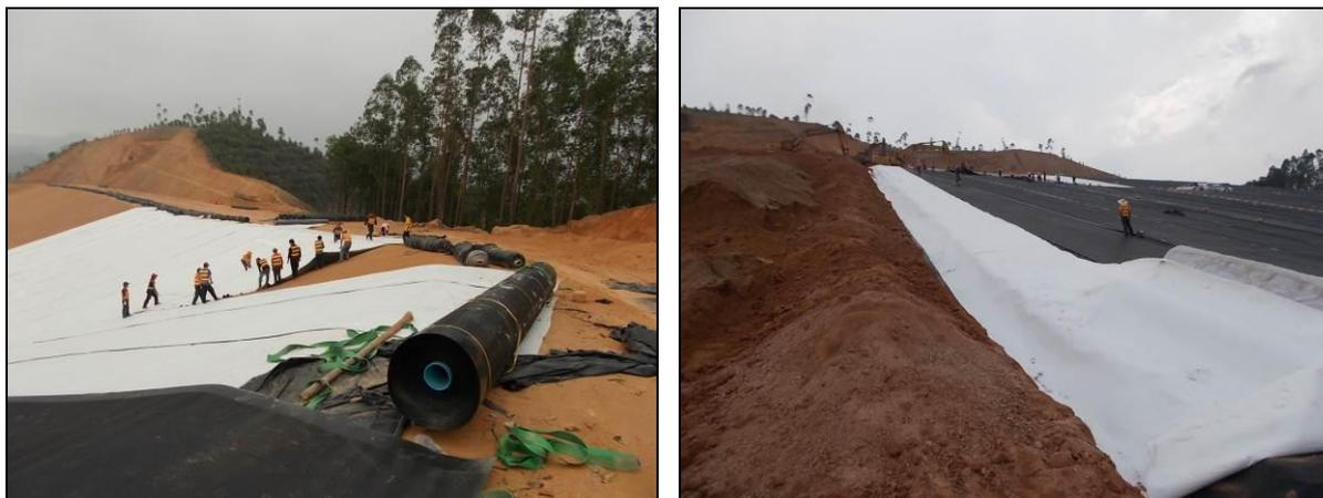
照片 9-5 填埋区底部防渗系统施工
