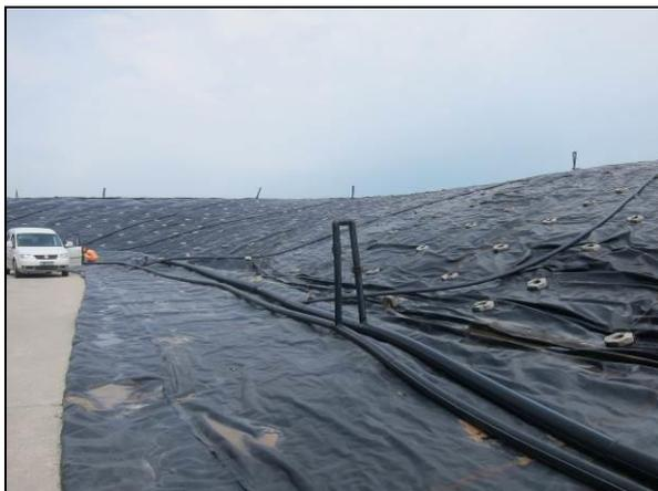
照片 3-1 填埋区气体收集管道
