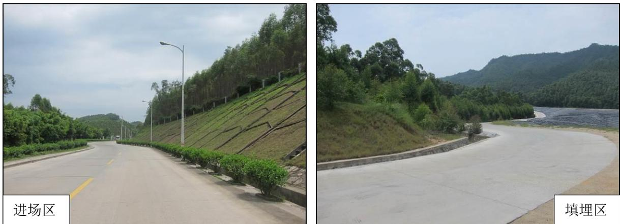
照片 7-4 进场区及填埋区道路两边护坡、边沟
